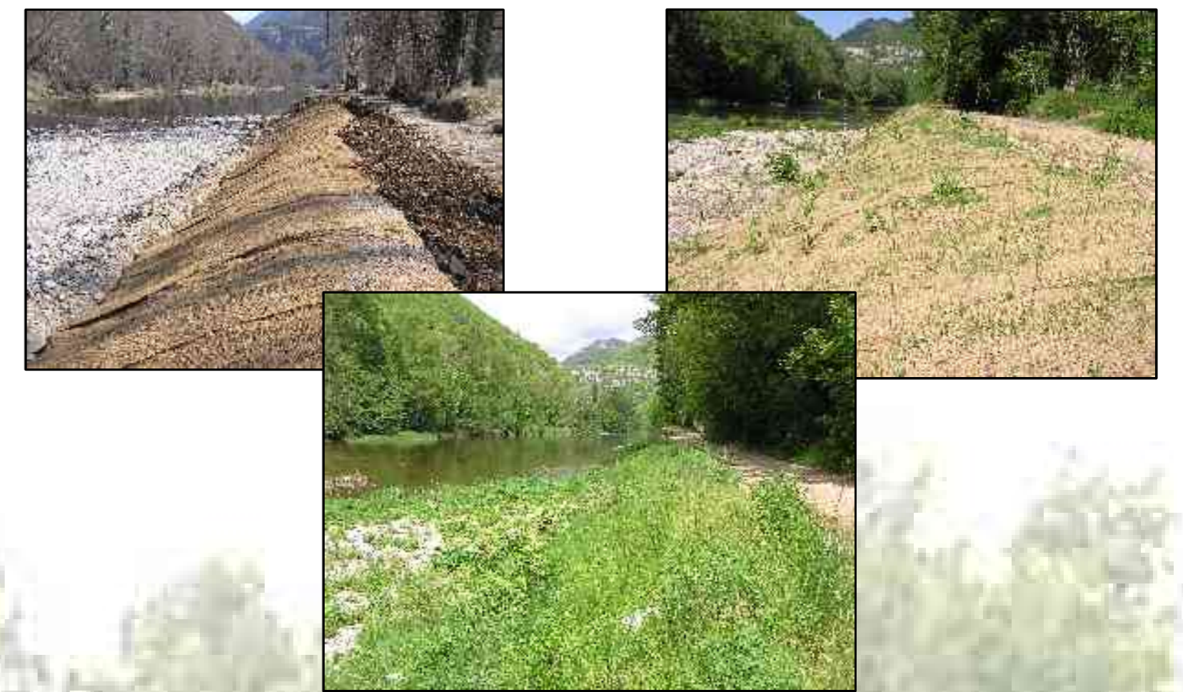
Reconstitution de la berge du chemin communal par apport de matériaux, mise en place d'une fascine en pied de berge (barrière constituée de fagots de saules bloqués entre des piquets en châtaigniers) géotextile, grainage et plantation.
