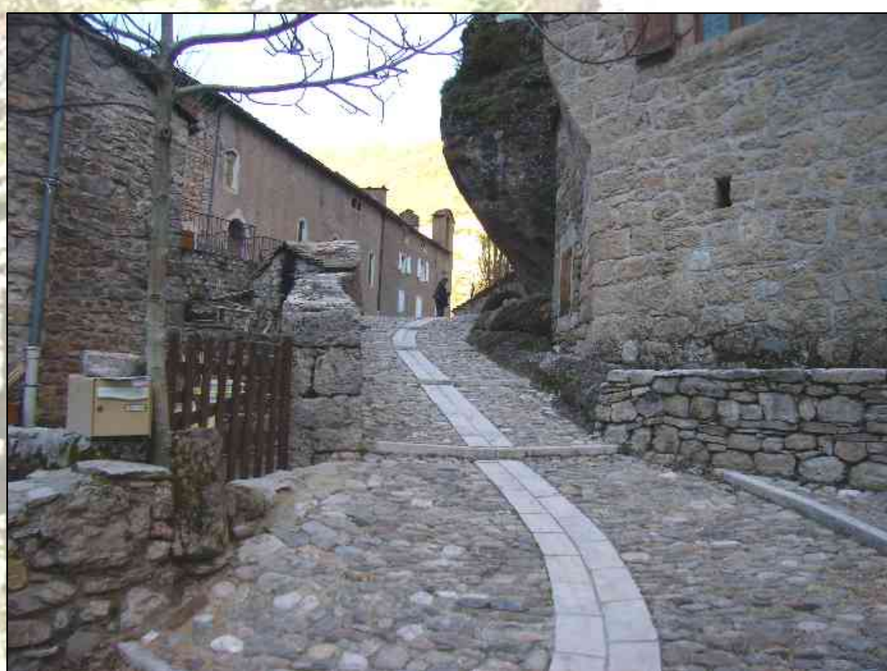
Réalisation d'une calade à Castelbouc
