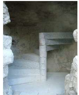
Réalisation escalier sur tour pour sortie de secours
