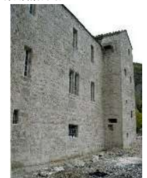
Bretèche au dessus de l'ancienne porte. Photo couleur, R. Pauget, S.D.A.P.
