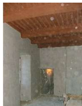
Dressage des murs intérieurs par réalisation d'un enduit fin
