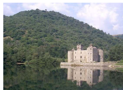
Château après incendie
