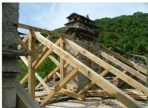
Élévation de la charpente de type ferme avec pannes et chevrons
