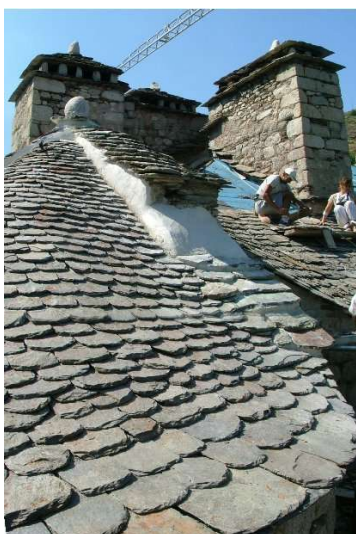
Détail noue arrondie Châssis de toiture pour accès entretien toiture
