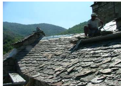
Pose des lauzes depuis rive jusqu'au faîtage
