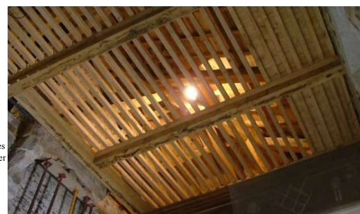
Poutres et solivages de plancher
