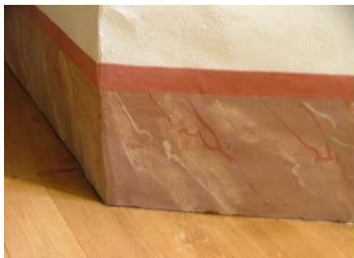
Réalisation de décor des plinthes en faux marbre sur salles du niveau 1
