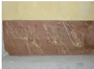
Réalisation de décor des plinthes en faux marbre sur salles du niveau 1
