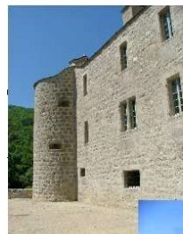
Réalisation joints extérieurs sur ensemble des façades
