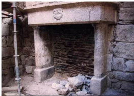
Reprise cheminée intérieure en pierre de taille
