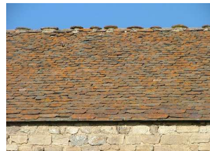
Lauze schistes de récupération avant dépose sur Grange (Provenance Carrière du Tournel)
