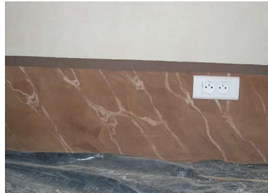
Réalisation de décor des plinthes en faux marbre sur salles du niveau 1
