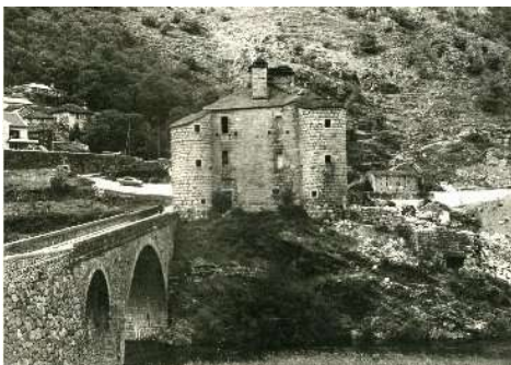
Façade méridionale de château (1966). S.D.A.P. De la Lozère, repro. R. Soulier
