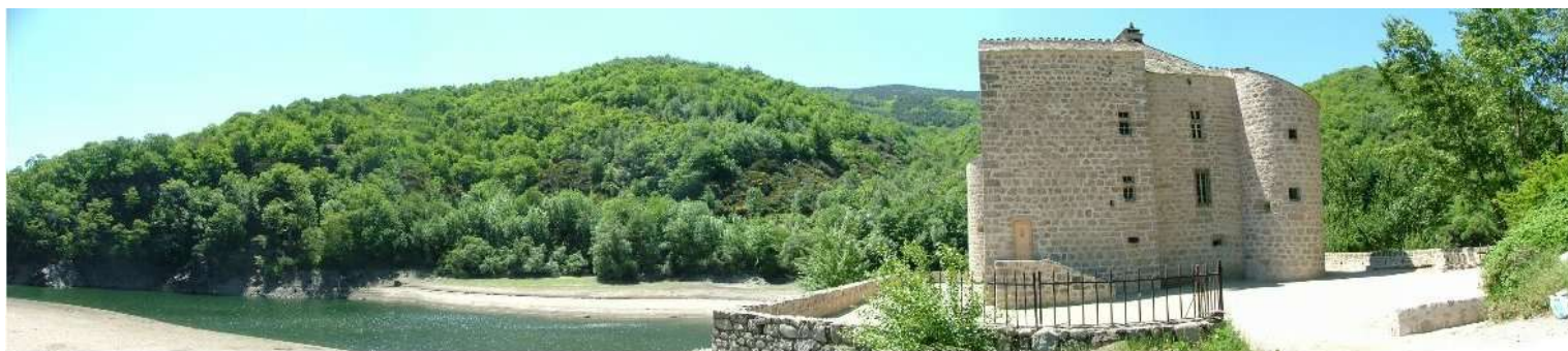
Vue générale enceinte du château et ses abords après travaux réalisés
