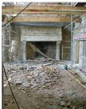
Reprise maçonneries intérieures en moellons de pierres
