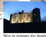
Mise en éclairage des façades
