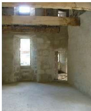
Réalisation de la première couche d'enduits : dégrossi ou gobetis à la chaux
