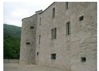
Façade est, bouches à feu sur la tour ronde. Photo couleur, R. Pauget, S.D.A.P.
