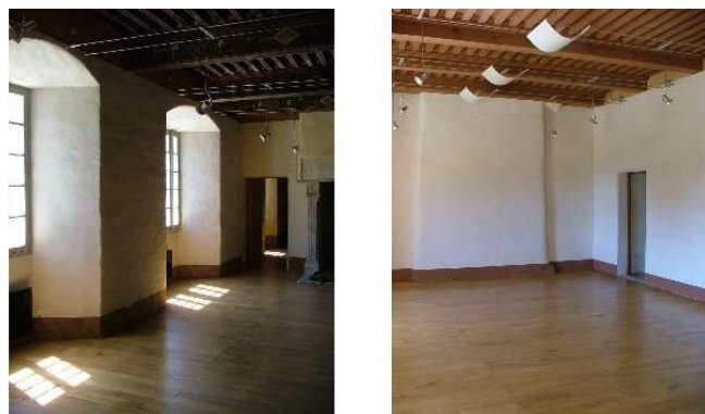
Parquets massifs réalisés sur ensemble des pièces
