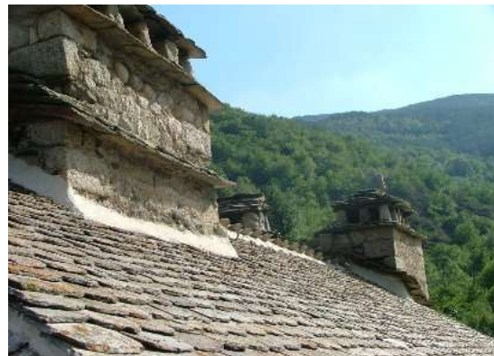
Abergement de souche de cheminée ainsi que double couronnement pierre conservés
