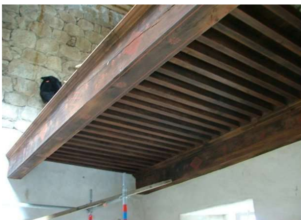
Réalisation plancher bois : poutres, solivages, lambrequins
