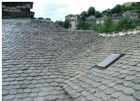
Détail noue arrondie Châssis de toiture pour accès entretien toiture
