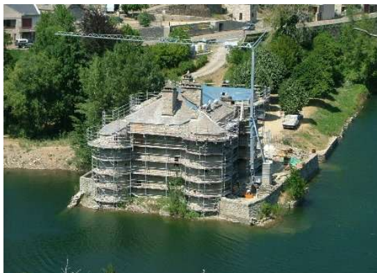
Vue aérienne pendant réalisation couverture
