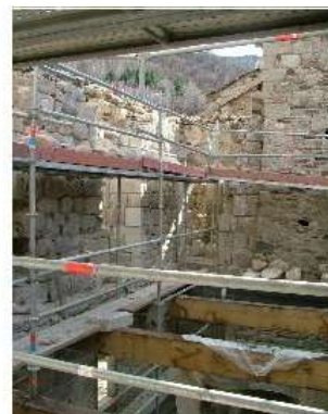
Reprise maçonneries intérieures en moellons de pierres
