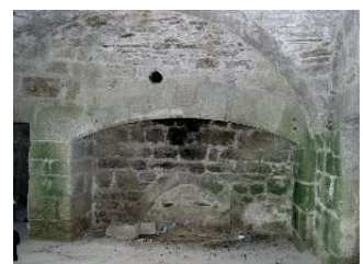
La cheminée du rez-de-chaussée et le petit four. Cliché A. Charrel, 2006 Repro N. Mercier
