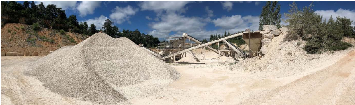
Point de vue n°5 : Vue d'ensemble sur la zone de traitement Source : ARTIFEX 2022
