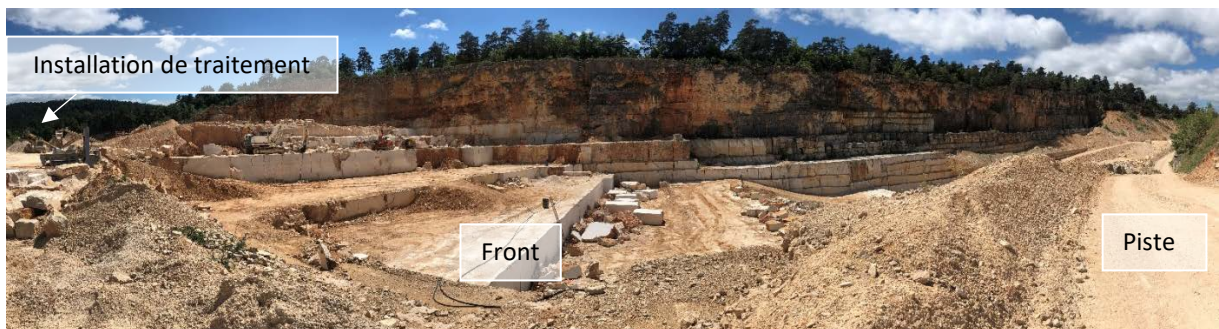
Point de vue n°4 : Vue d'ensemble sur la zone d'extraction Source : ARTIFEX 2022
